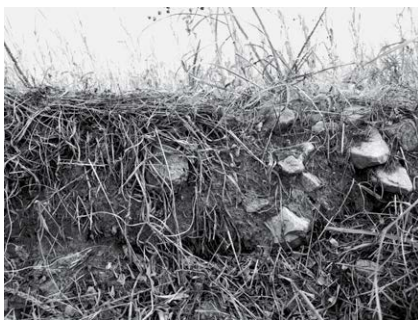
图 14 哈达外城墙的夯土构造 (作者自摄)
