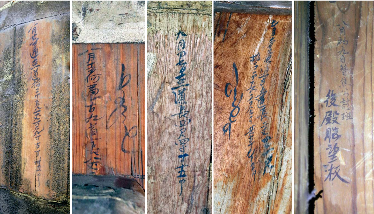
a) 前殿西一次间东缝后檐九架梁 b) 前殿东一次间东缝九架梁题记 c) 后殿东二次间前檐上金枋 d) 后殿明间后檐上金枋题记（作者 e) 后殿东一次间前檐脑望板题记（作者自摄）
