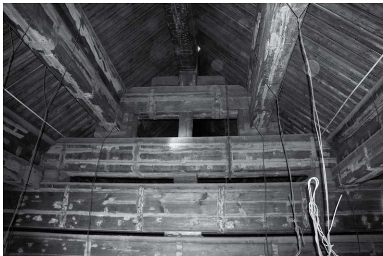
图22 奉先殿前殿梁架局部 (作者自摄)
