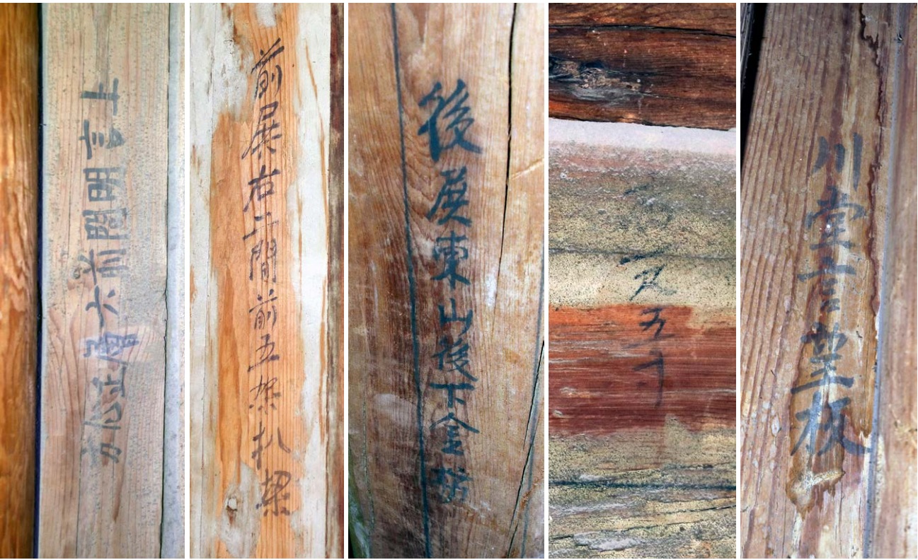
a) 前殿上层明间前檐斗拱题记 (作者自摄) b) 前殿西二次间前檐斗拱题记 (作者自摄) c) 后殿东稍间西缝下金枋题记 (作者自摄) d) 后殿东三次间后檐中金枋题记 (作者自摄) e) 穿堂明间西侧檐步望板题记 (作者自摄)
