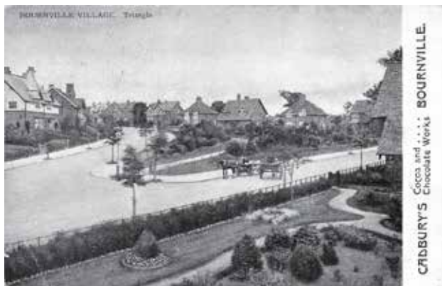
图 20 伯恩维尔村三角广场街景，1906 年 (Bournville Village Trust)
