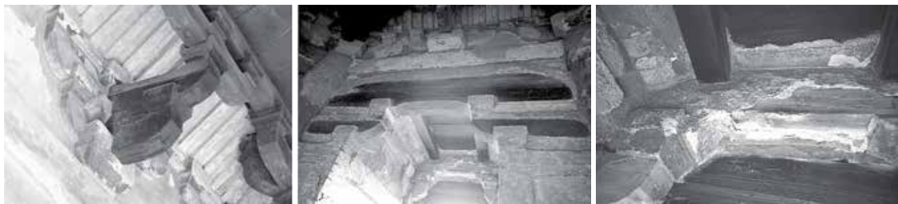
图5 瑞光塔砖木混合情况 (作者自摄)
