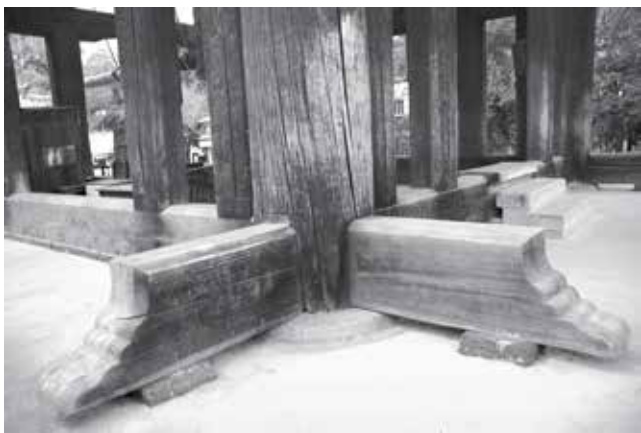
图 25 奈良东大寺钟楼地串形式（13 世纪初） （作者自摄）
