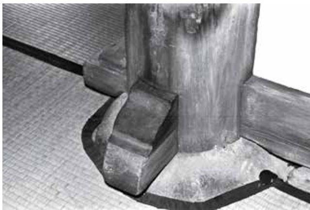
图 26 奈良东大寺开山堂地串形式 （奈良県文化財保存事務所。國寶東大寺開山堂修理工事報告書 [M]. 奈良：奈良県教育委員会，1971.）
