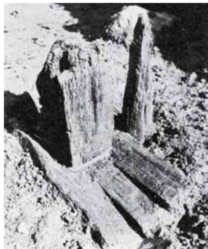
图9 浙江余姚河姆渡遗址干栏建筑木柱残段及柱础板做法(中国科学院自然科学史研究所,中国古代建筑技术史[M].北京:科学出版社,1985.)
