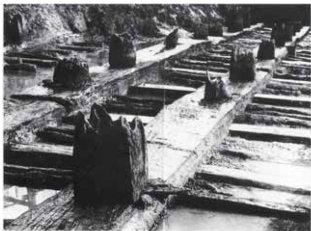
图11 南越王宫苑建筑遗址的地袱基础[罗雨林,张宁秋.愿历史早日展现真颜——记“南越王宫苑里假船台”论证会[J].华中建筑,2008(12):164-168.]
