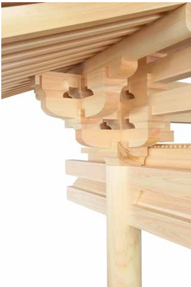
图3 奈良药师寺东院堂 1:2 模型檐下斗栱 (2019 年包慕萍摄于保国寺竹中大工道具馆中国特别展《哲匠之手》)
