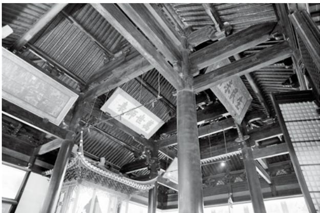
图5 大成殿室内梁架
